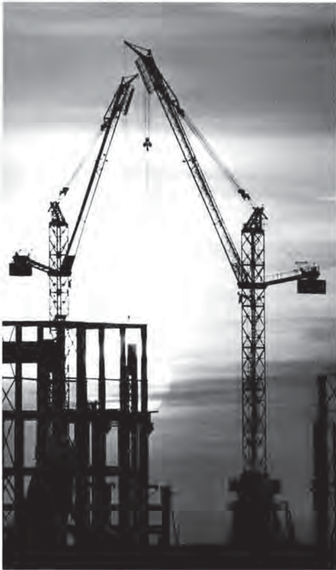
Фото 242. «Каркас реакторного корпуса Курской атомной станции».
